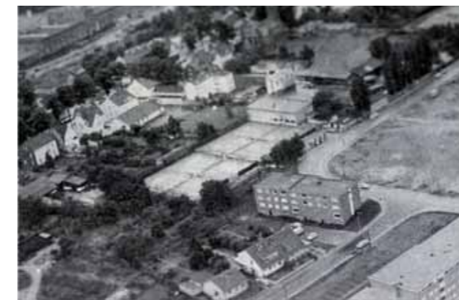
Luftbild der 4-Platzanlage Lochnerstrasse
